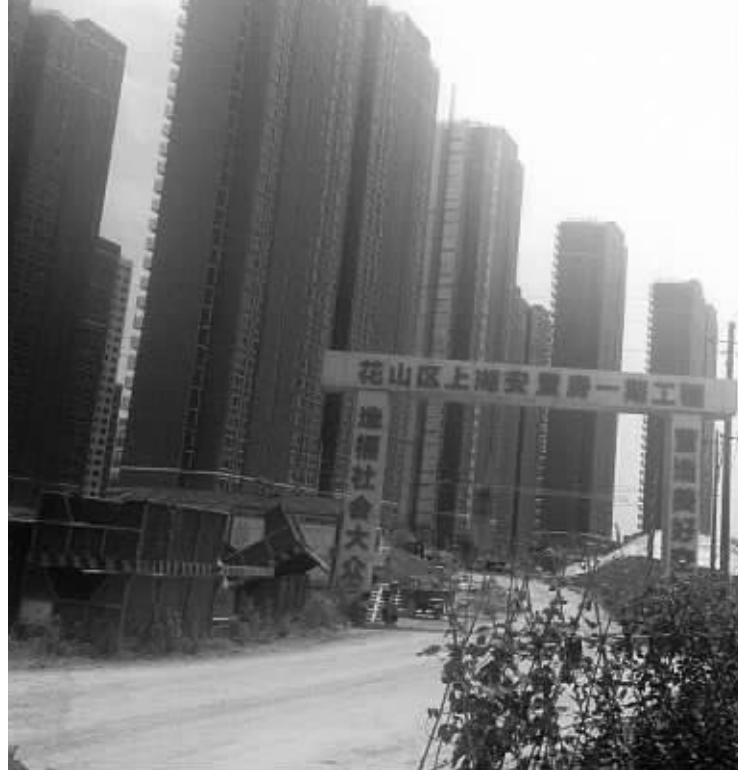
马鞍山上湖安置房小区一期工程已基本完工,正在扫尾。 本报记者曹学平/摄影
