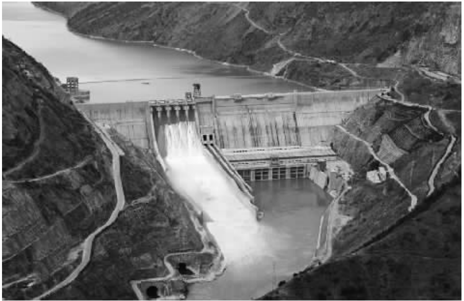
金安桥水电站
