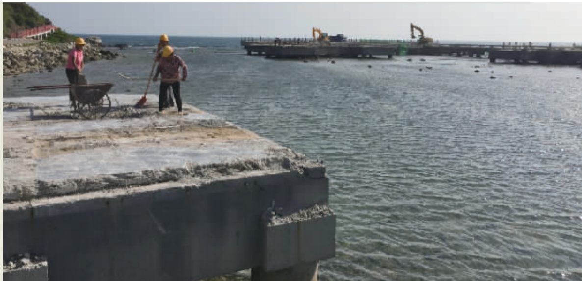
位于三亚的半山半岛洲际度假酒店配套“海上餐厅、游艇码头及栈桥”项目未批先建，对珊瑚礁生态造成了较大影响，已被责令拆除恢复原状。图为项目拆除现场。
