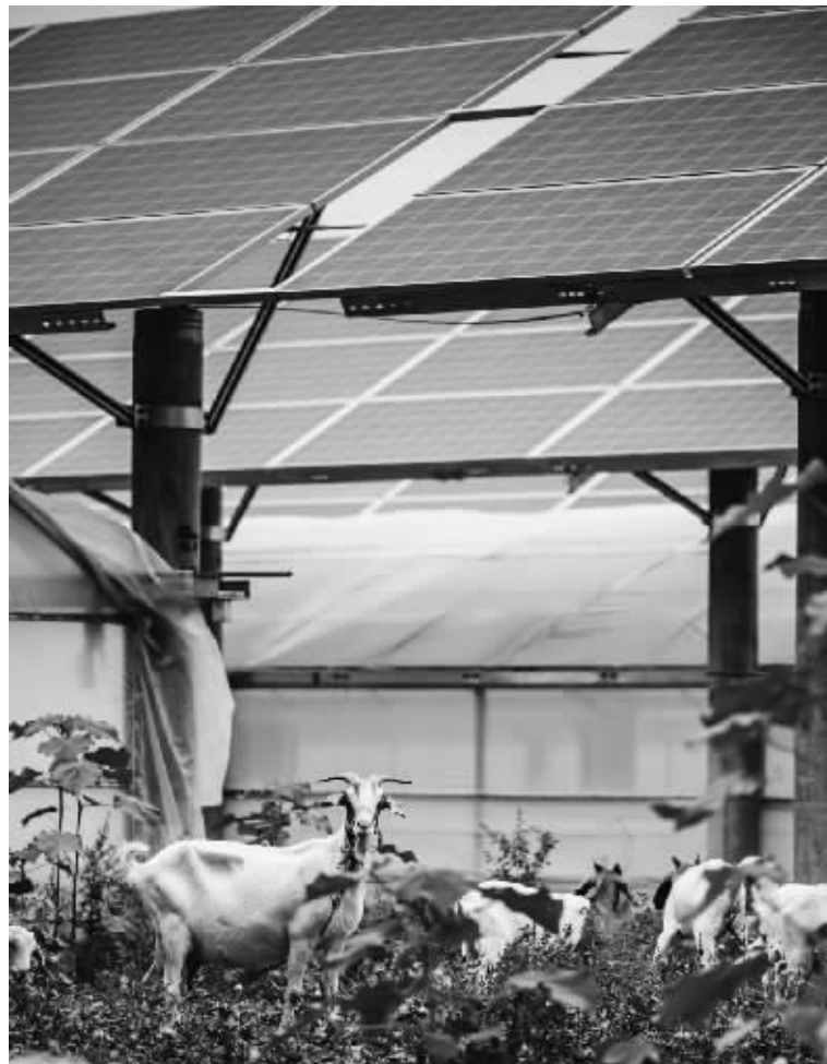
协鑫新能源郓城鑫华40兆瓦光伏扶贫电站。 本报资料室/图
