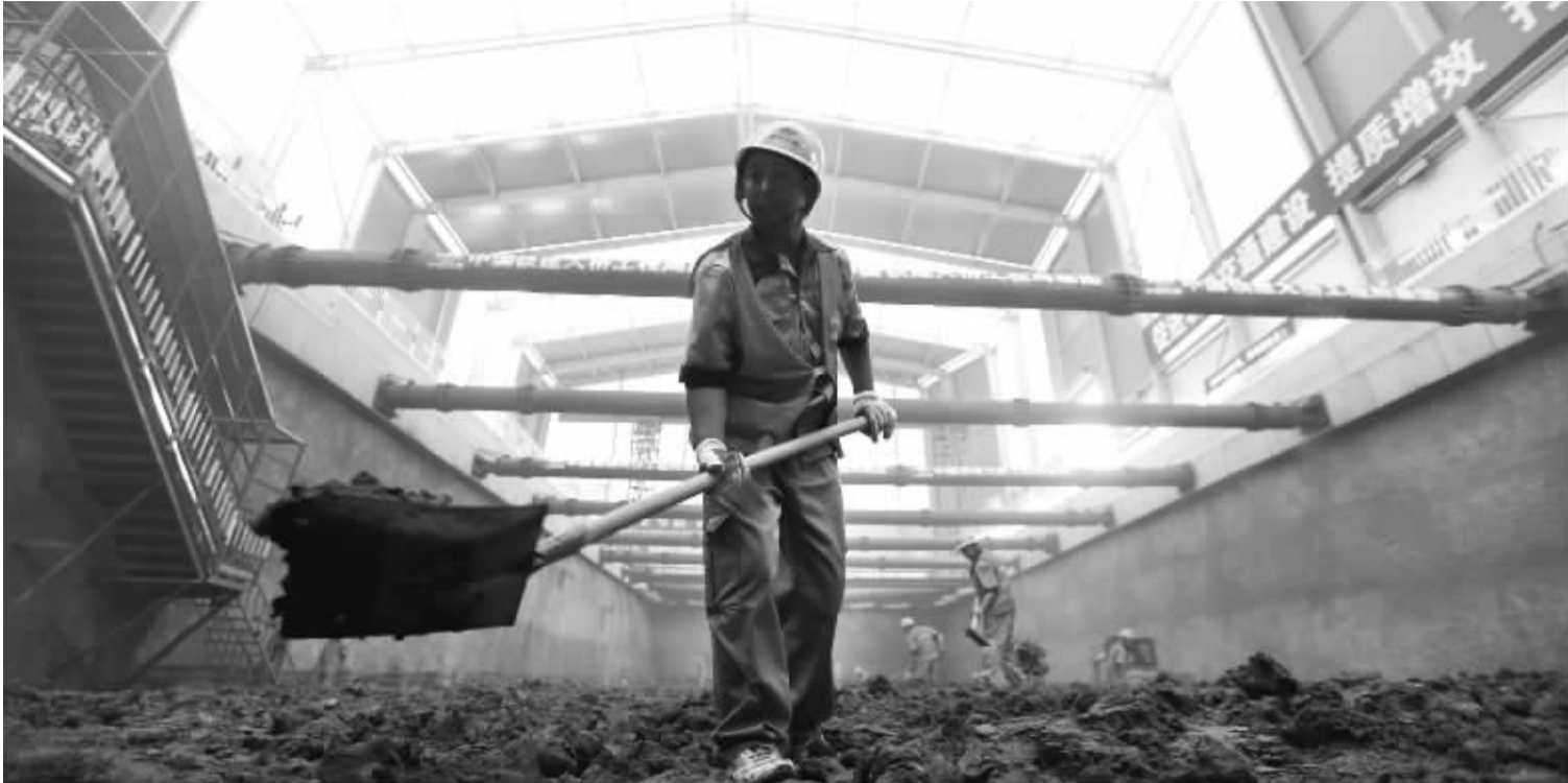
2018年5月10日,北京。一个长75.5米、宽40米,相当于3个标准游泳池大小的膜结构防尘隔离棚,出现在北京地铁17号线香河园站建设工地。
