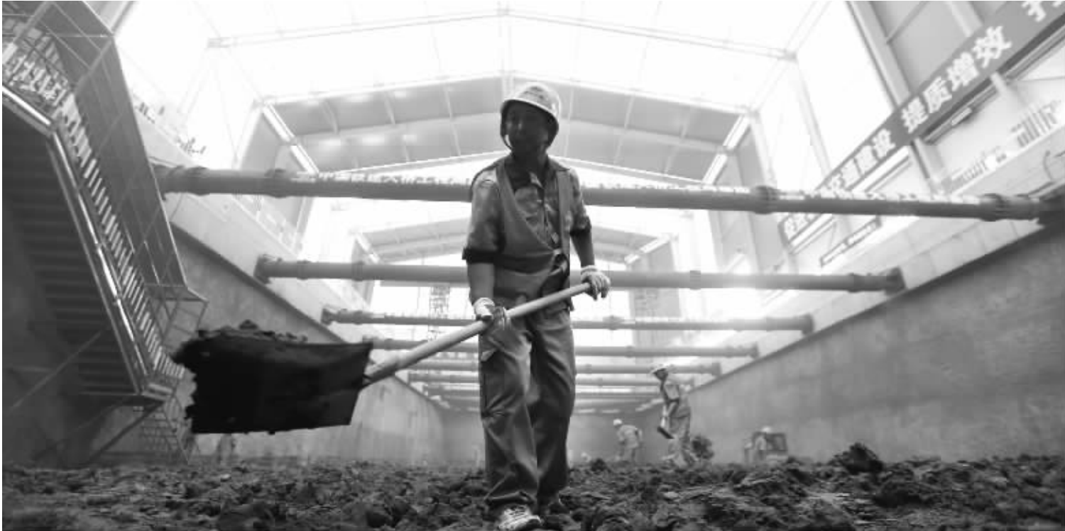
2018年5月10日,北京。一个长75.5米、宽40米,相当于3个标准游泳池大小的膜结构防尘隔离棚,出现在北京地铁17号线香河园站建设工地。
