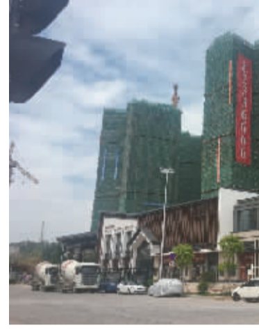
在建的奥园天悦湾项目。
