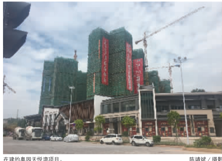
在建的奥园天悦湾项目。
