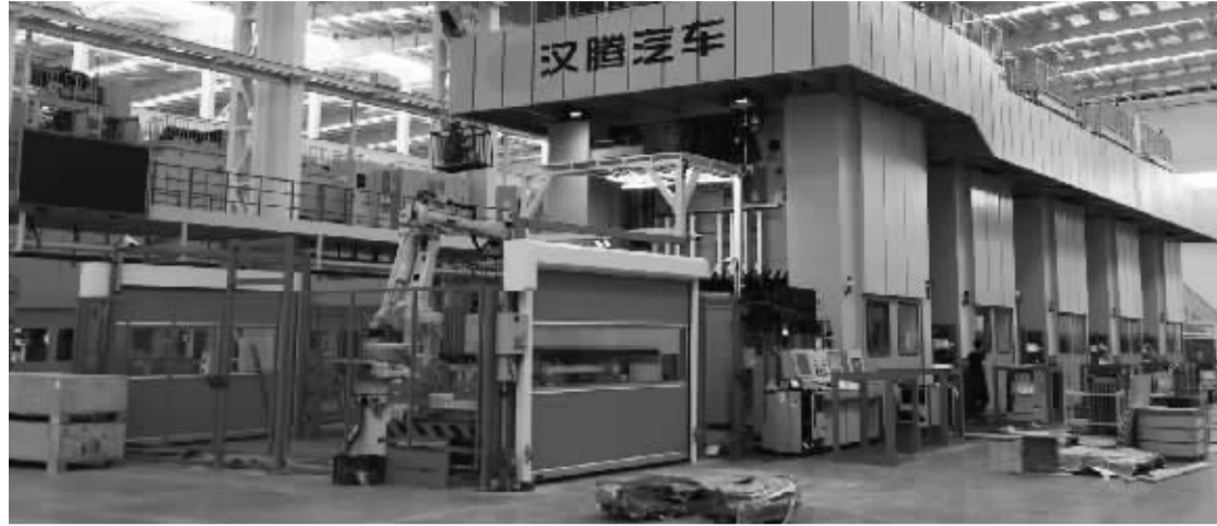
汉腾汽车产业园二期项目车间
