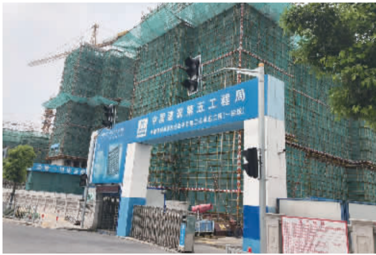
日前，记者在上海市浦东新区周浦镇林海公路与年家浜路交叉口的保利周浦地王工地现场看到，项目售楼处被蓝色围挡拦住，但工地现场仍有百余工人在施工。毛中楠/摄影
