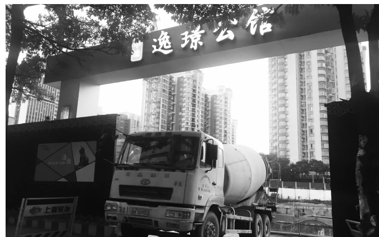
中冶逸璟公馆侧门，有水泥车进进出出，历经两年多仍在施工。
