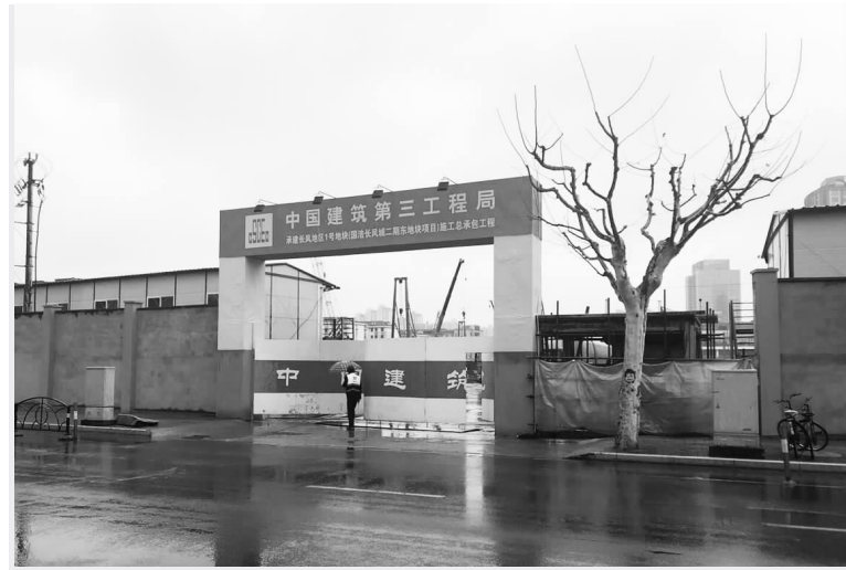
尽管位于上海市普陀区大渡河路的国浩长风正在施工，但记者并未发现其有施工铭牌。毛中楠/摄影
