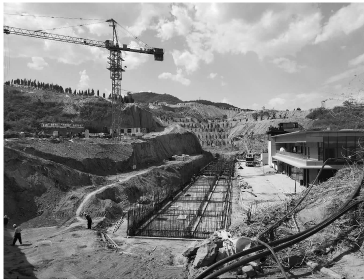
太原西山官山城郊森林公园,半山坡的工地上许多工人和车辆正在作业,正在施工建设“官山院子”住宅项目。黄永旭/摄影
