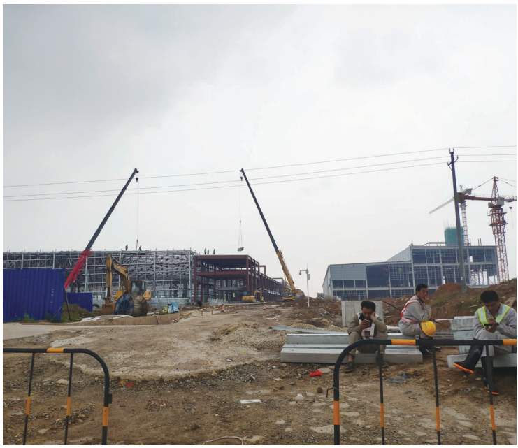
从外面看,厂房的主体架构已经基本建成。
