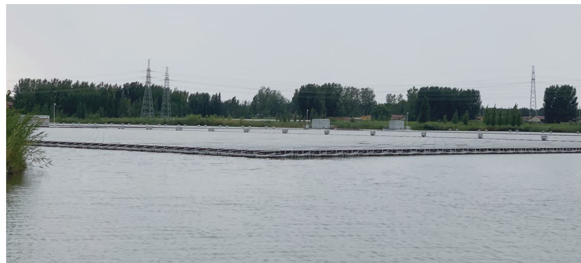
阳光电源微山欢城50MW光伏领跑者项目。
