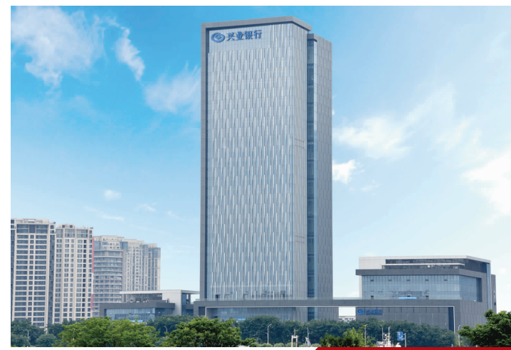
2019年兴业银行正在兴建的福州营运中心崛起于闽江之滨，投入使用后将大大改善该行的办公条件。 杨家起/摄影
