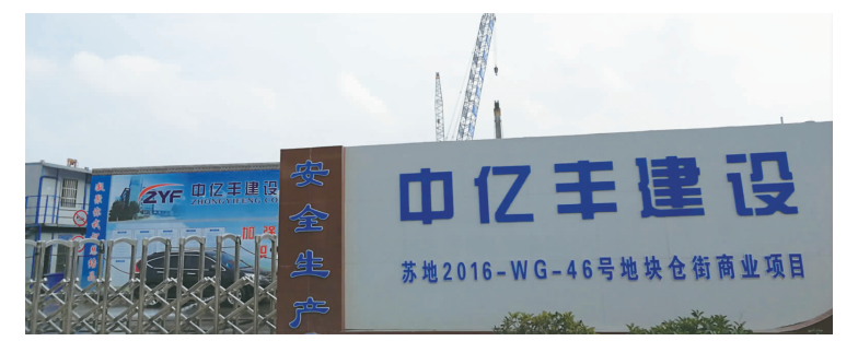
仁恒藕前商业项目施工现场，中亿丰建设员工对记者称：“今年上春就开始建了，打桩都一个多月了，现在挖土挖了十来天了。”
