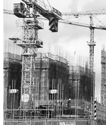
2019年5月14日，广西南宁市五象新区一处正在建设中的商品住宅楼盘。 本报资料室/图
