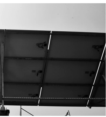
光伏支架等产品支撑起中信博的半壁江山。图为某光伏项目建设现场。 本报资料室/摄
