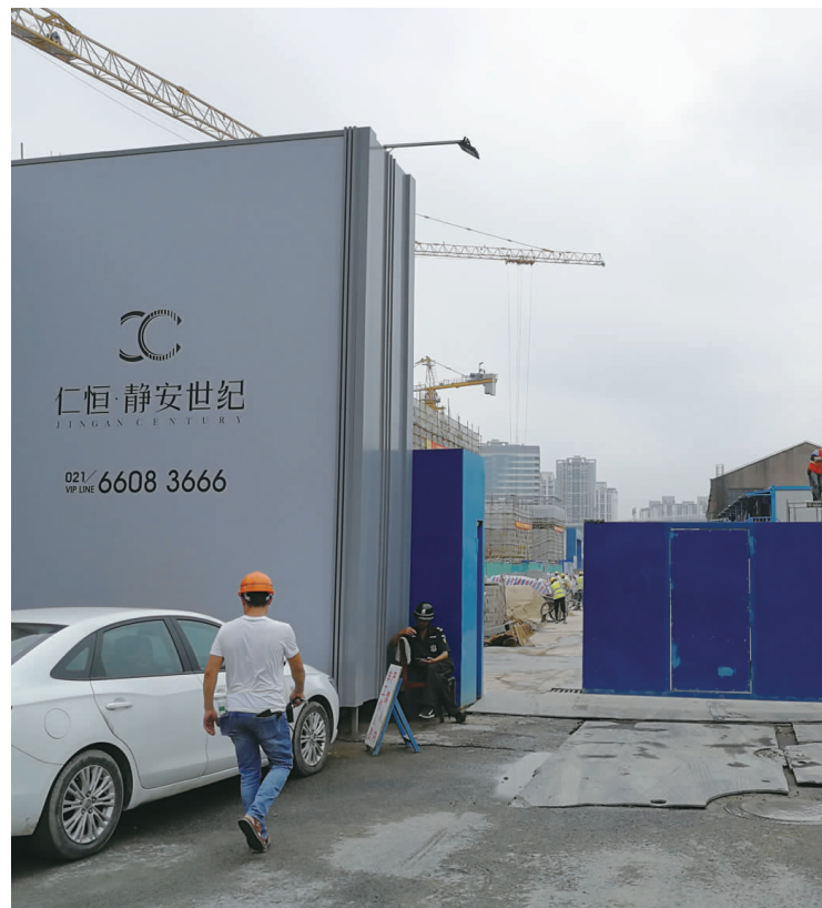
仁恒静安世纪项目工地入口，销售人员表示，大概7月20日左右，针对验资客户开放该处工地样板房。方超/摄影
