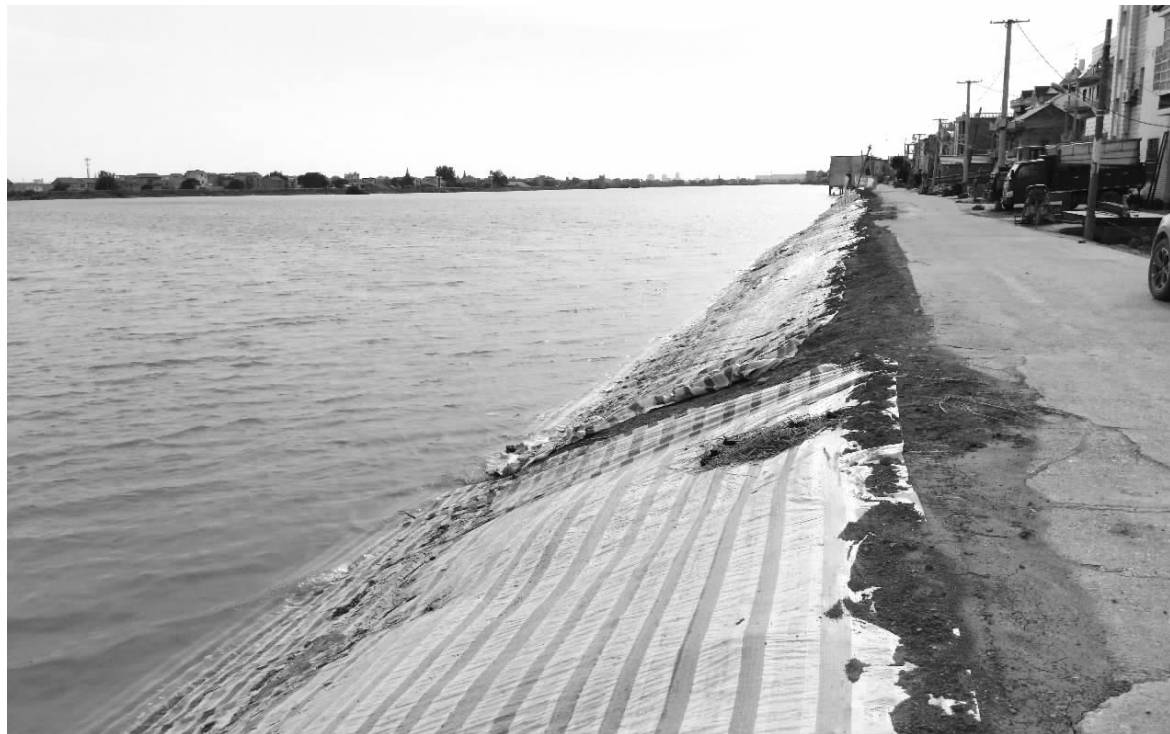
昌洲乡圩堤的抢险加固方式之一，是填充泥土，再用塑料彩条布覆盖。这些土质防护堤的加强部分，究竟能在多大程度上经受住洪水的冲刷/摄影
