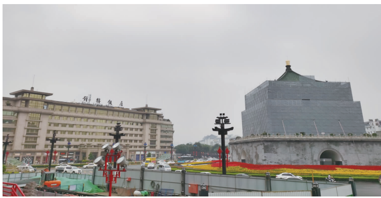
位于古都西安市中心、建于1384年的西安钟楼正在维修中。
