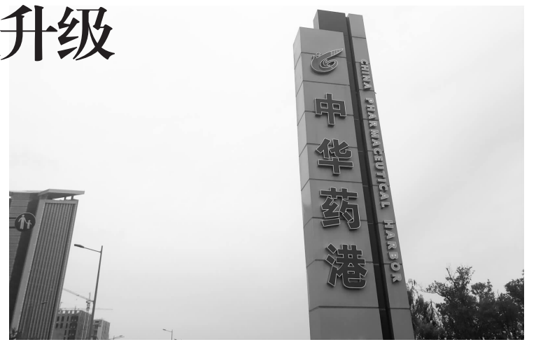
聚焦“中华药港”核心区项目的建设，连云港力图推进新医药产业转型升级和产业集聚。目前一期大部分建筑已经封顶，预计8月便将陆续有项目入驻。 郭阳琛/摄影
