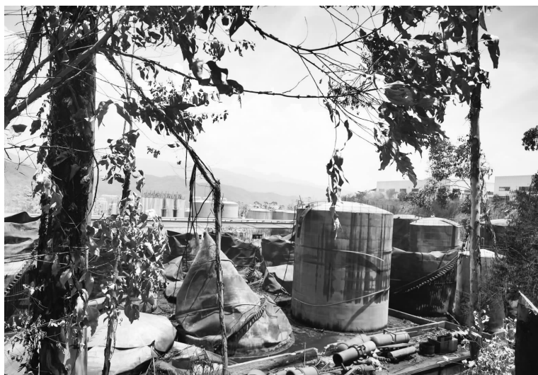
发生火灾事故的储油罐体已被烧得面目全非。
