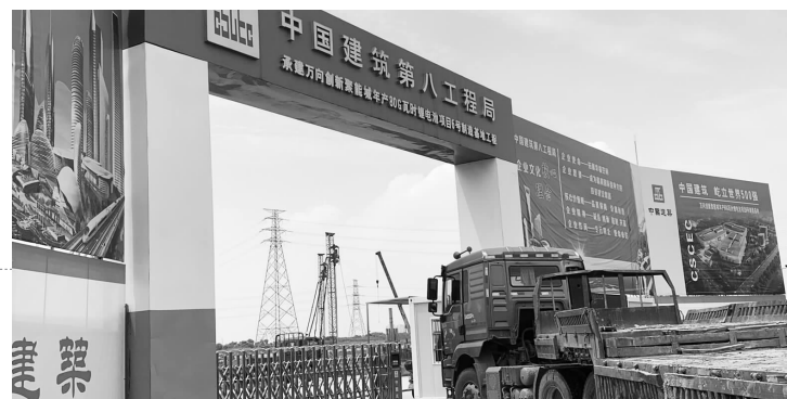
7月21日，记者来到万向创新聚能城现场，发现该工地开工一年多仍在进行最基础的打桩工作。刘媛媛/摄影
