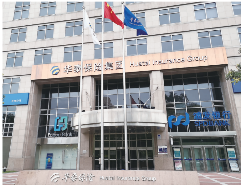
位于北京金融街的华泰保险集团大厦。
