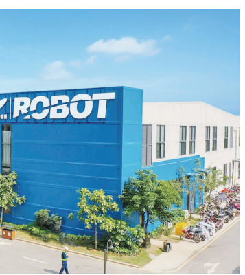
佛山顺德机器人谷的博智林机器人实验中心。
