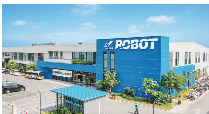
佛山顺德机器人谷的博智林机器人实验中心。
