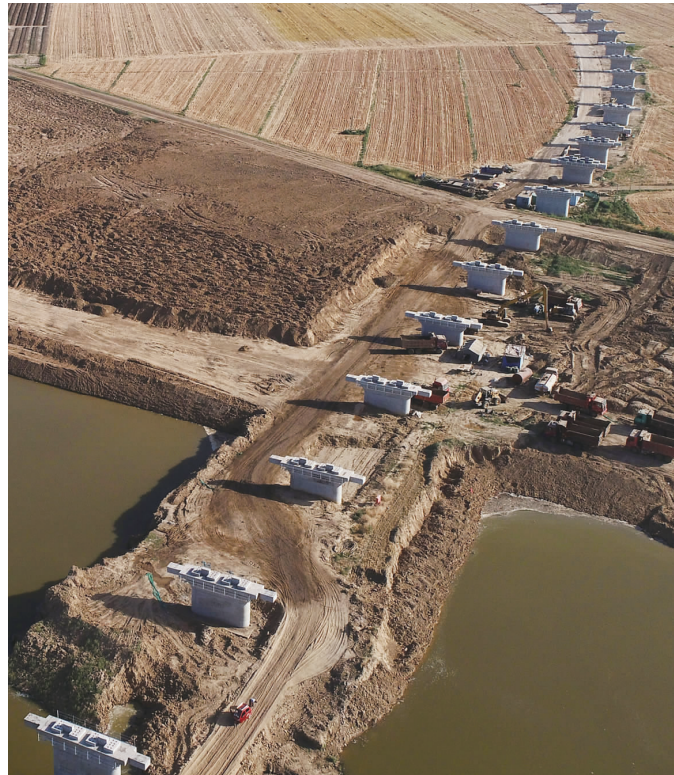
对地方而言,铁路建设的带动作用依然非常突出。图为不久前,山东滨州一处货运铁路专线建好的桥墩。 本报资料室/图
