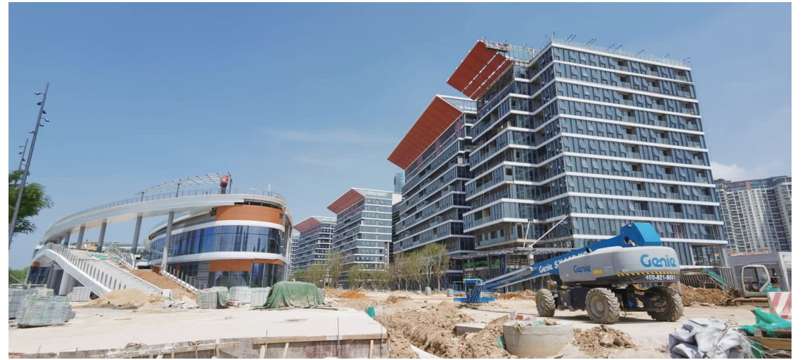
深圳一处正在建设的写字楼。
