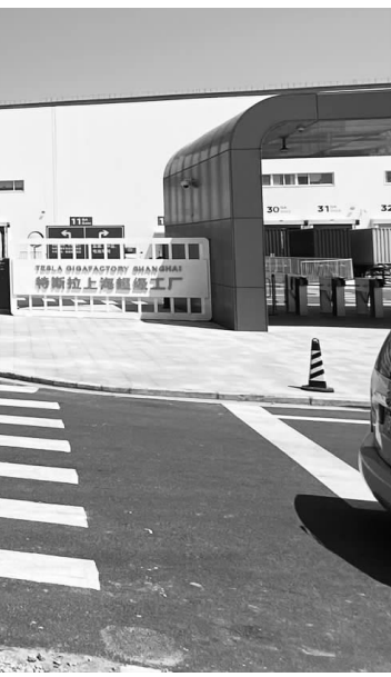
位于上海临港的特斯拉上海超级工厂，二期工程已进入收尾阶段。
