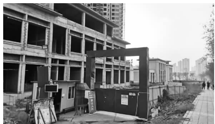
阳光望江榭项目尚未完工,但目前工地内看不到任何施工人员。
