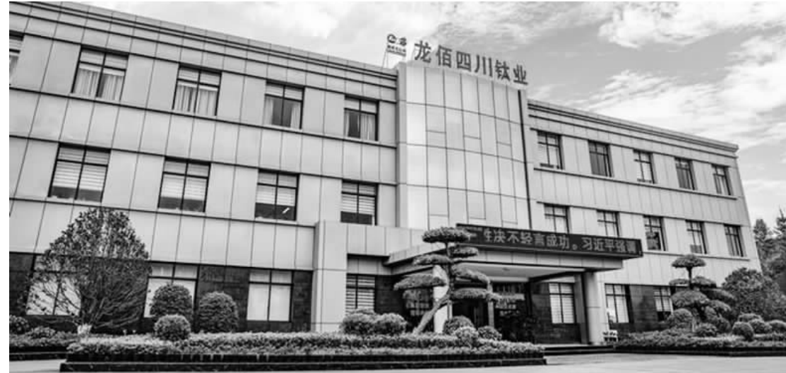
图为龙蟒佰利四川德阳公司厂区。
