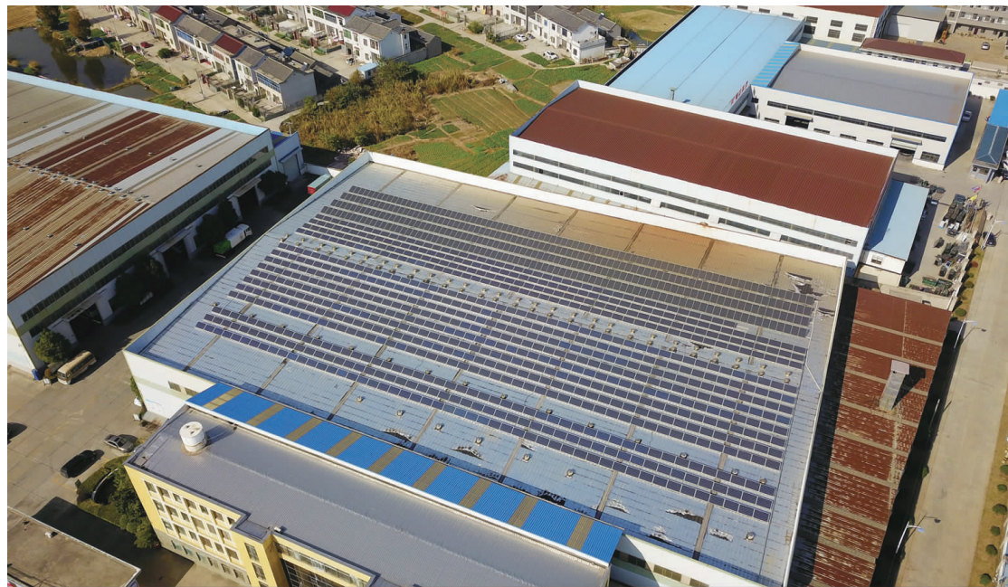
江苏扬州厂房屋顶光伏发电项目。
