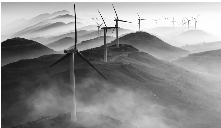
图为国内某地风电场。
