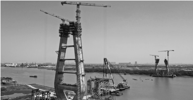
广东一季度GDP继续领跑全国,逼近3万亿元。图为4月10日拍摄的粤港澳大湾区南中高速洪奇门特大桥主桥吊装架设首片钢箱梁施工现场。
