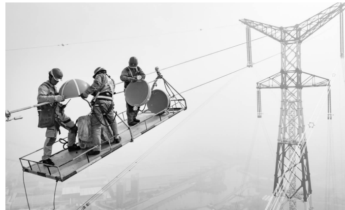
白鹤滩—江苏±800千伏特高压直流输电工程建设现场。
