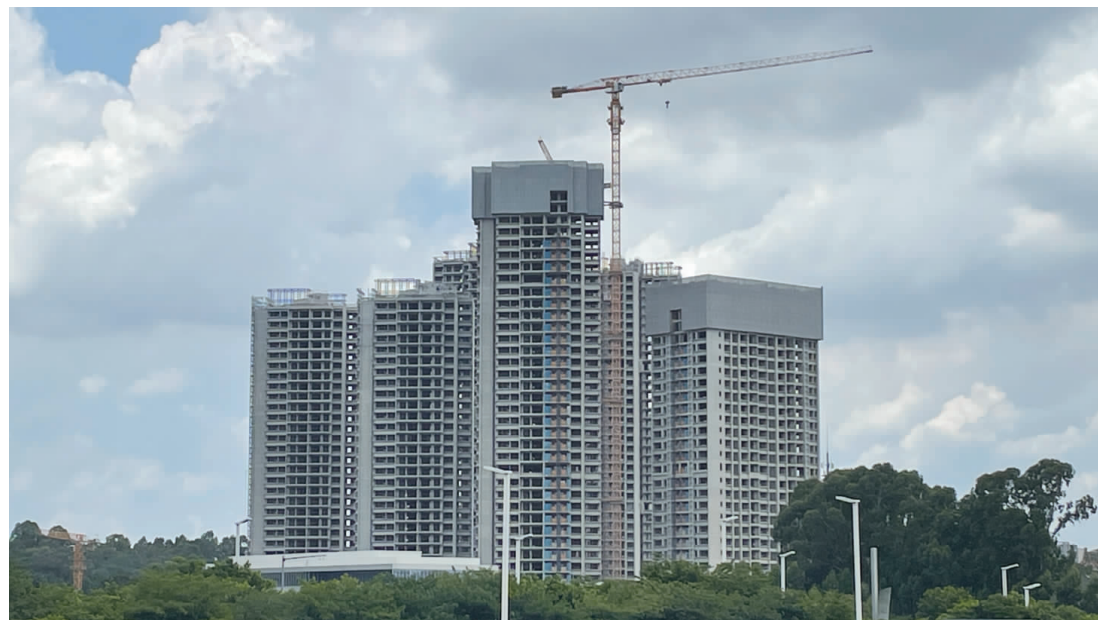
广州南村万博区域一楼盘施工现场。
