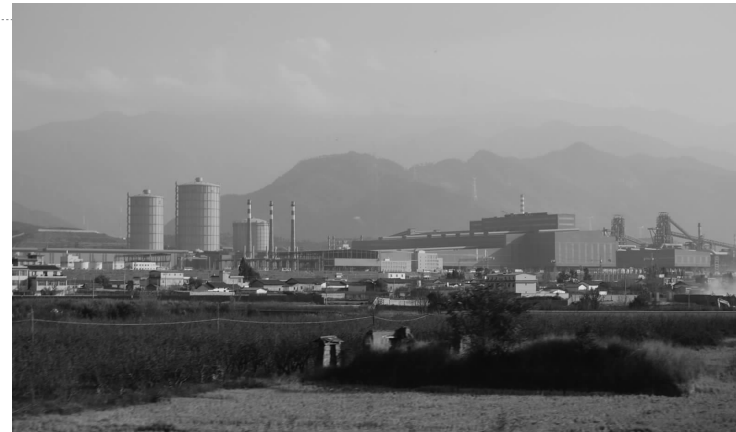
攀钢西昌钒钛资源综合利用项目。
