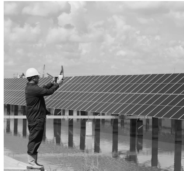
位于黑龙江大庆的光伏电站项目。
