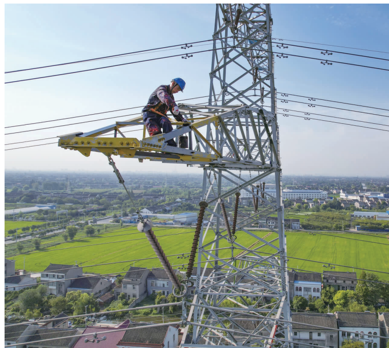
近期,全国用电负荷创历史新高。图为8月10日,江苏靖江工作人员正在为220千伏塔架刷漆。视觉中国/图
