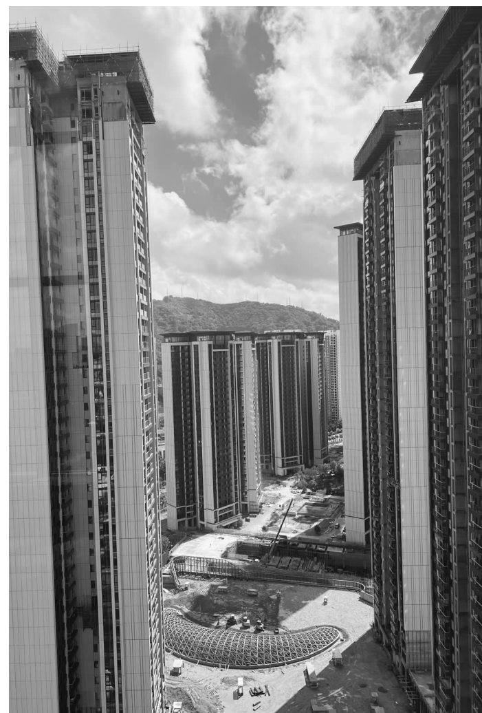
东莞某楼盘施工中。
