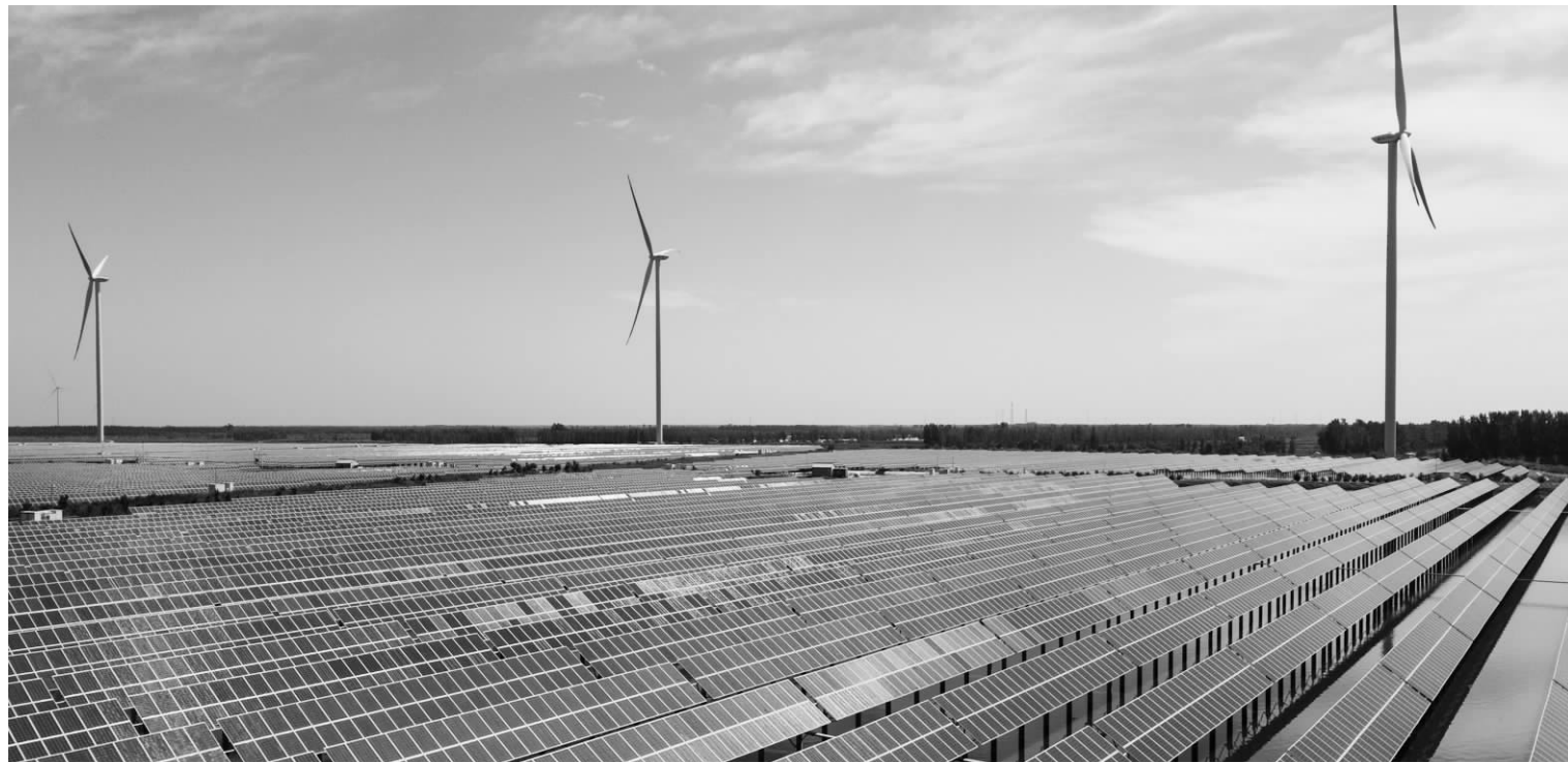
受益于光伏产业的快速发展，高纯石英砂和石英坩埚成为重要的“抢手资源”。图为天津市宁河区宁河镇110千伏大河光伏电站。
