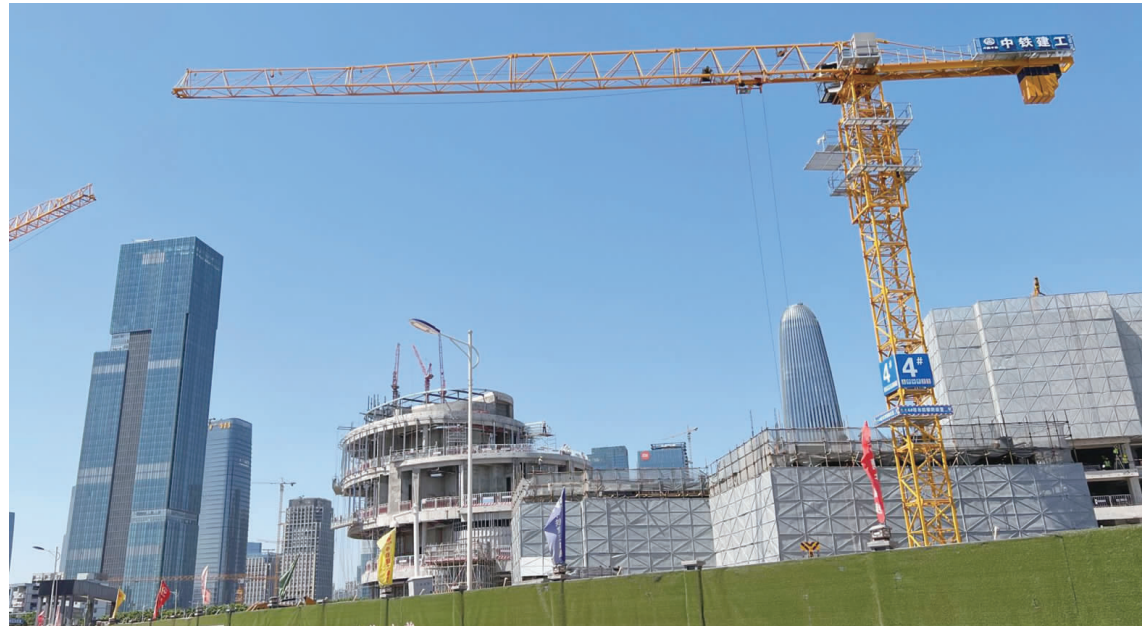
深圳一楼盘正在施工中。
