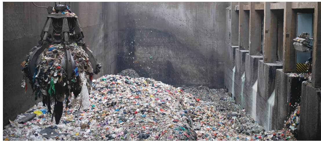
广东正构建集污水、垃圾、固体废弃物、危险废物、医疗废物处理处置设施和监测监管能力于一体的环境基础设施体系。图为广东省广州市福山循环经济产业园的垃圾吊进行垃圾处理工作。
