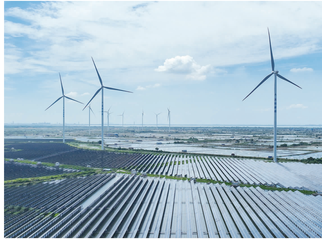
在碳中和目标推动下,光伏产业发展迅猛,态势一如既往地火热。图为江苏省常州市武进区前黄镇的渔光互补光伏发电基地。 视觉中国图
