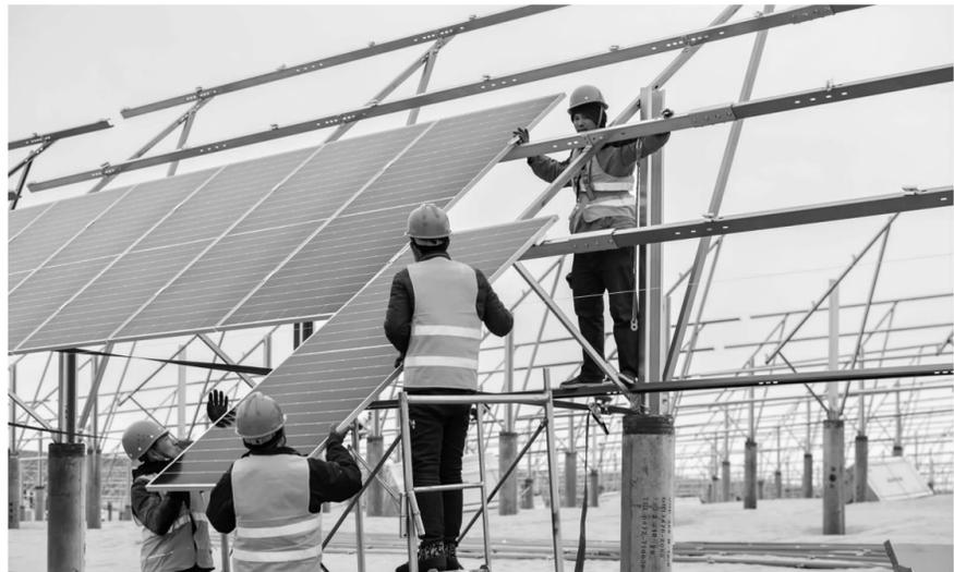
近年来,随着光伏产业的快速发展,EVA产品供应大幅增加。图为工人在内蒙古达拉特旗100MW光伏治沙农牧综合示范项目建设现场安装光伏板。视觉中国/图
