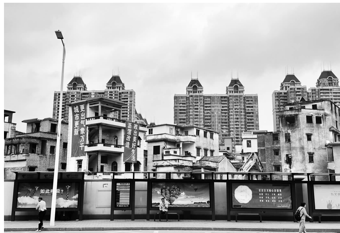
广州沥滘村旧改项目施工现场。
