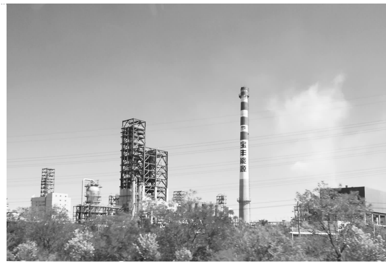
近日，宝丰能源公告披露，其位于内蒙古鄂尔多斯市的300万吨“绿氢+煤”制烯烃项目一期已正式开工。图为银川宝丰能源厂区。视觉中国/图
