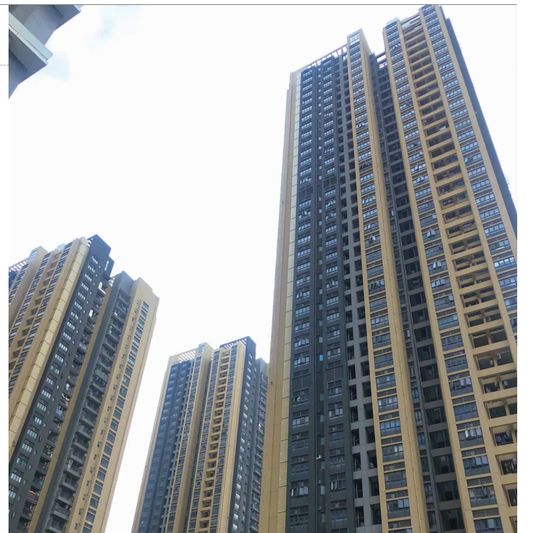
深圳市宝安区一处存量住房项目。
