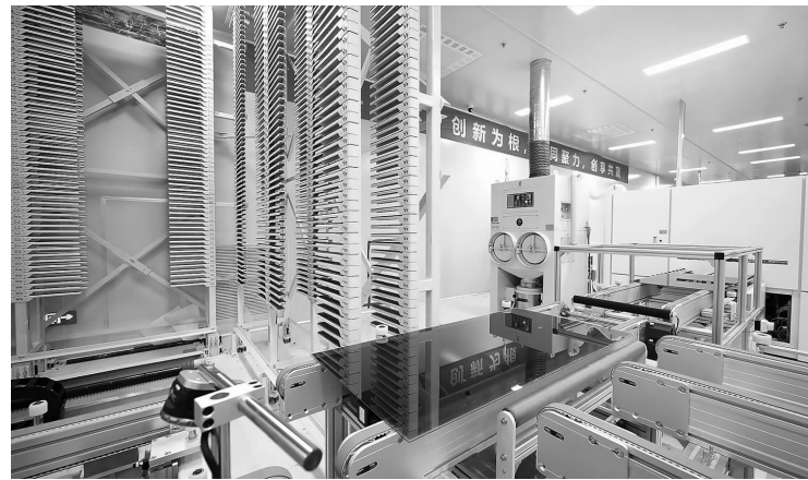
极电光能150MW钙钛矿光伏生产线。
