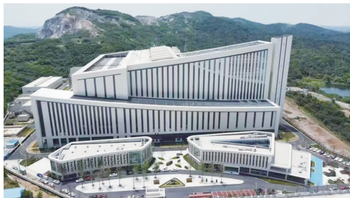
财务公司牵头组建银团建设的合肥龙泉山垃圾发电项目已经成为当地最大的垃圾焚烧企业，每年净利润接近6000万元。
