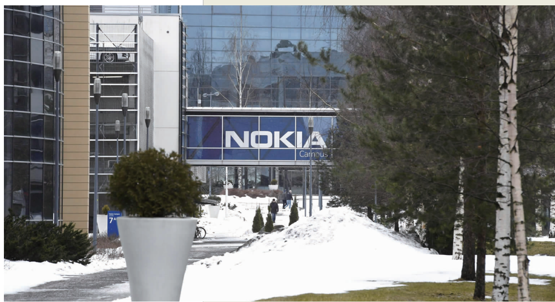
芬兰埃斯波诺基亚总部。
